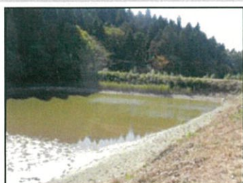
水が抜かれた高堤
