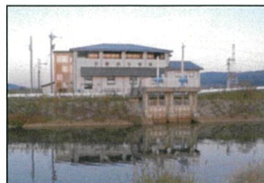
余喜排水機場
