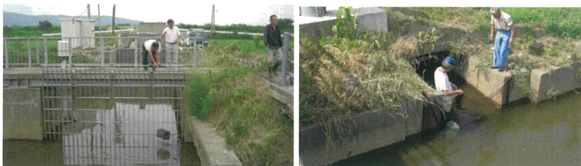
カゴ網、定置網設置作業状況
