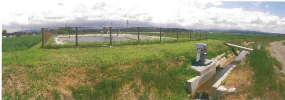
調査を行った揚水機場調整池
