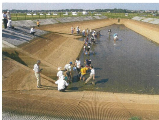
調整池の水を吐出し水位を下げ調査を実施
