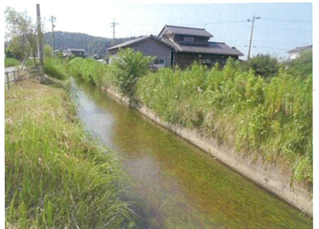
[028] 調査箇所(No.8 邑知小横水路)
