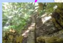
BB2203 寺家町 水路補修L=30m 283,580円
