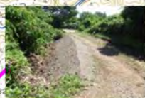
BE2201 滝谷町 法面補修 (イノシシ被害) 189,200円
