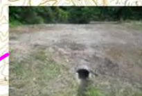
BB2202 寺家町 横断暗渠補修 L=5m 257,400円
