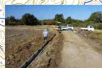
BE2202 滝谷町 BF300布設替(2箇所) L=120m 92,413円
