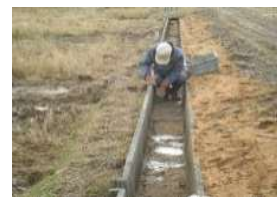
目地詰め作業
