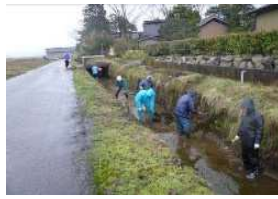
江掘り状況写真
