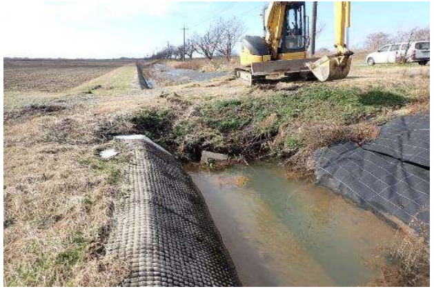
横断暗渠破損による排水不良
