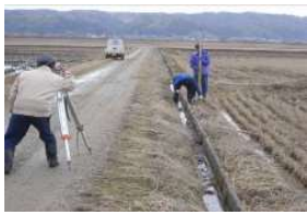
測量・丁張り作業
