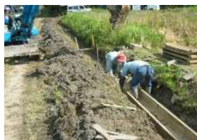
U字溝布設作業
