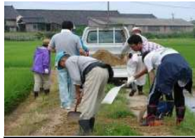
農道補修状況写真
