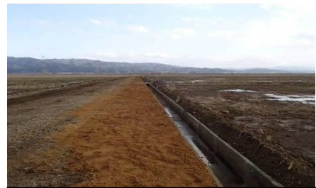
作業前、作業後の写真
