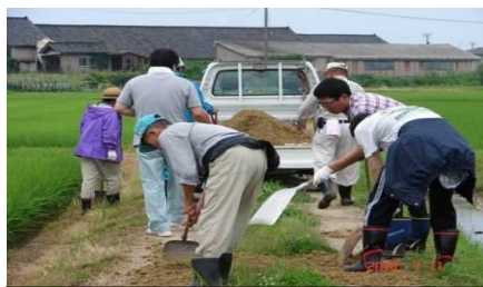
農道補修状況写真
