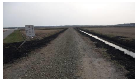
作業後の写真
