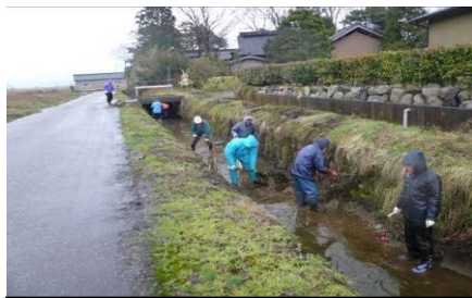
江掘り状況写真
