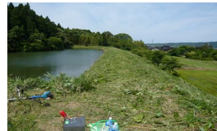
作業後の写真
