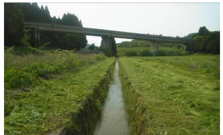
作業後の写真
