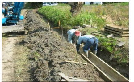
U字溝布設作業
