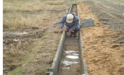
目地詰め作業
