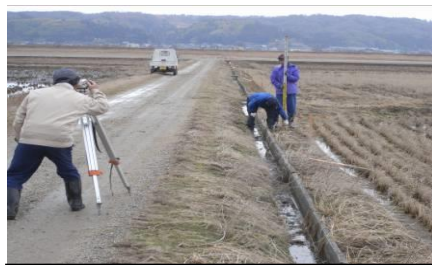
測量・丁張り作業
